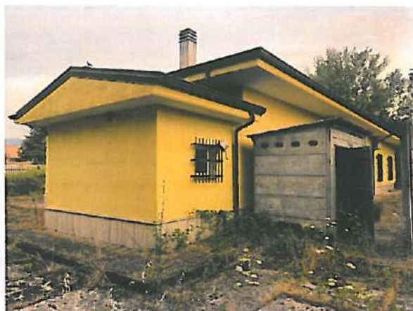
Vista Sud-Est - corpo A
