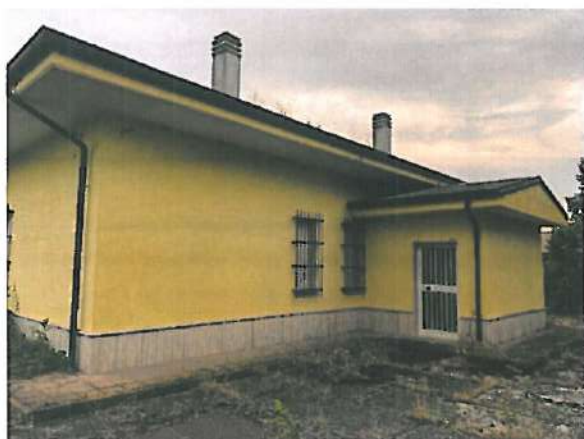
Vista Nord-Est - corpo A
